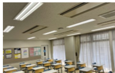
新しく設置されたLED照明
